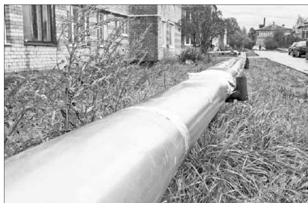
Новая теплотрасса. ФОТО: ЗС ТВЕРСКОЙ ОБЛАСТИ
