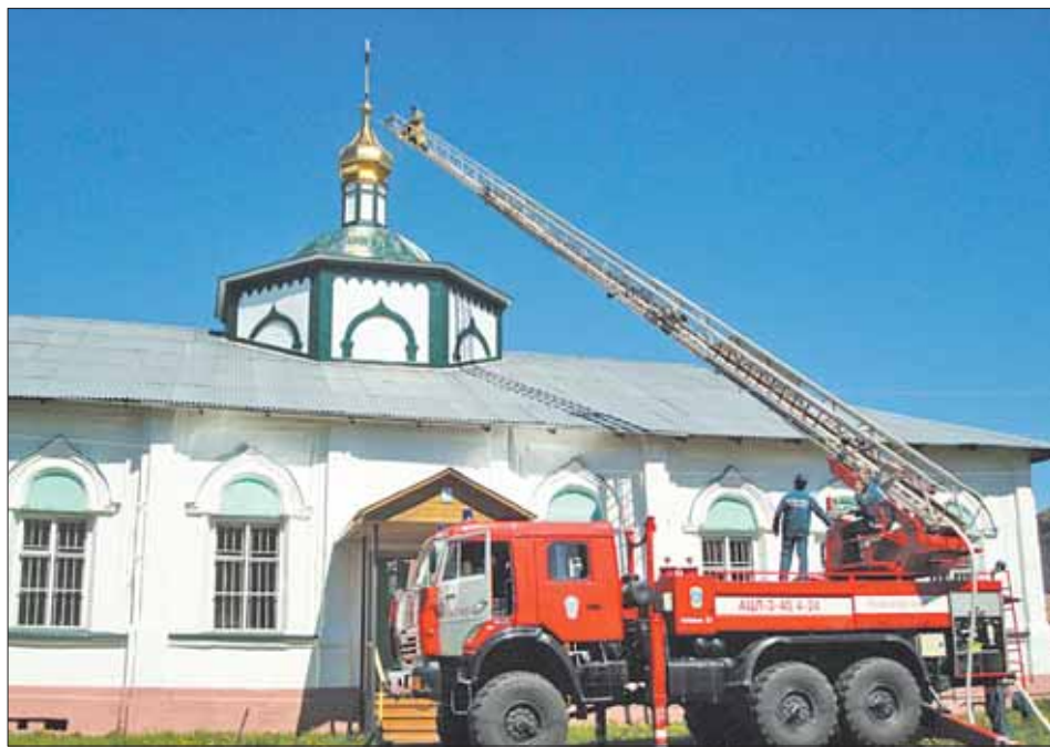
Александр Беляков устанавливает шипы, не позволяющие птицам хозяйничать на крыше и куполах. ФОТО: VES.BLAGOCHIN.RU.
