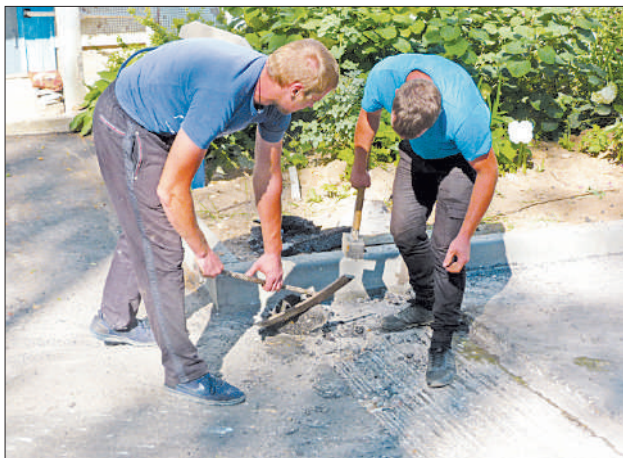
Ржевское ДРСУ уложило асфальтовое покрытие в шести дворах. ФОТО: АРТУР ПАШКОВ, «ТЖ»
