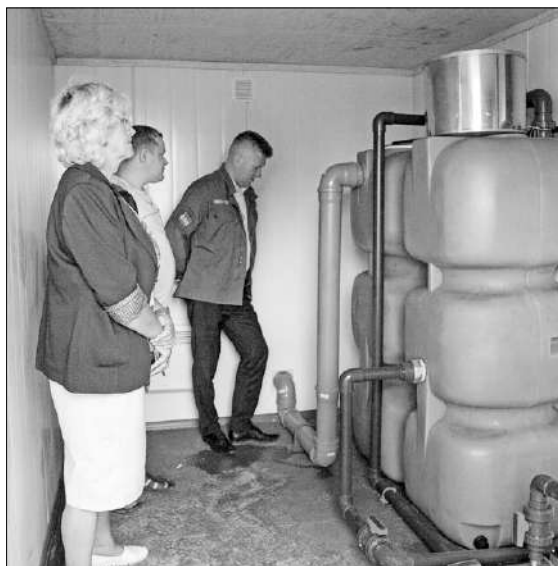
Приемка руководством Удомельского городского округа станции очистки воды в д. Казикино. ФОТО: СВЕТЛАНА МИХАЙЛОВА
