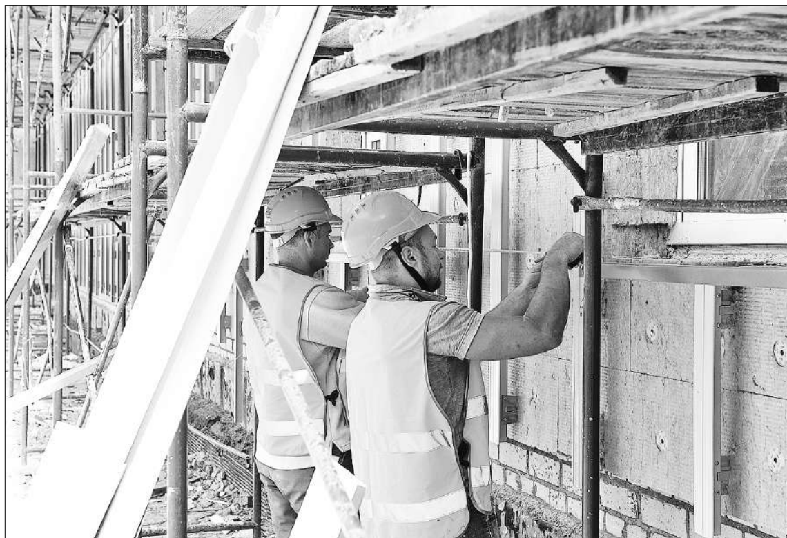
Строительство поликлиники должно быть завершено к сентябрю. ФОТО: КОНСТАНТИН БЕЖЕЦКИЙ
