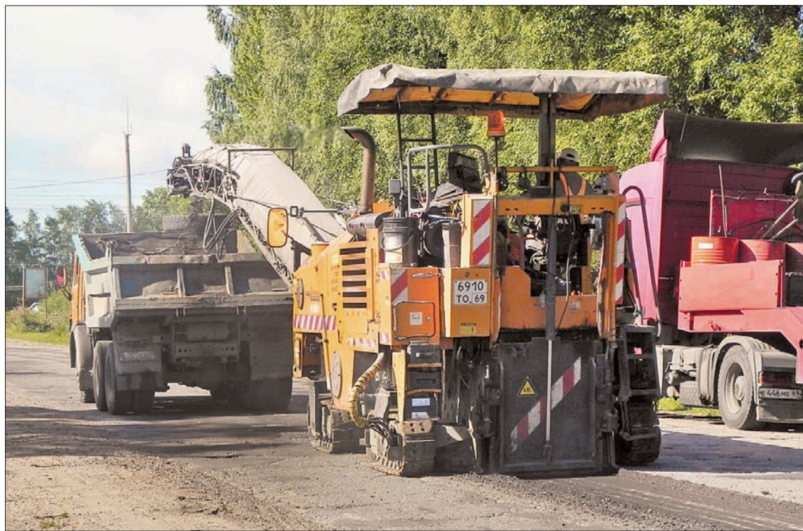
В Оленинском районе начался большой ремонт. ФОТО: БЛОГ ОЛЕГА ДУБОВА
