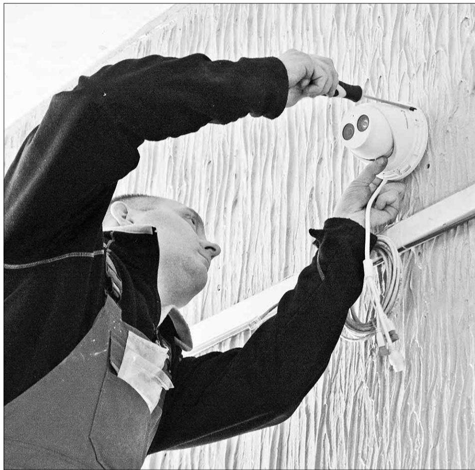
Идет монтаж видеокамер. ФОТО: АЛЕКСАНДР СОЛОДКОВ, «ТЖ»
