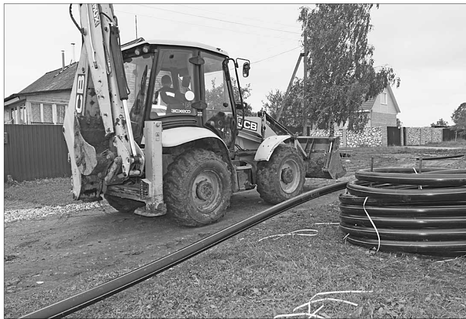
Идет ремонт водопровода в деревне Бороздино. ФОТО: СВЕТАНА МИХАЙЛОВСКАЯ
